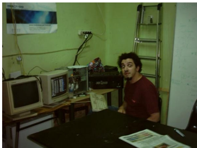
Deal, integrante del hacklab, instalando Asterisk en el servidor para crear una centralita telefónica por internet con software libre.
