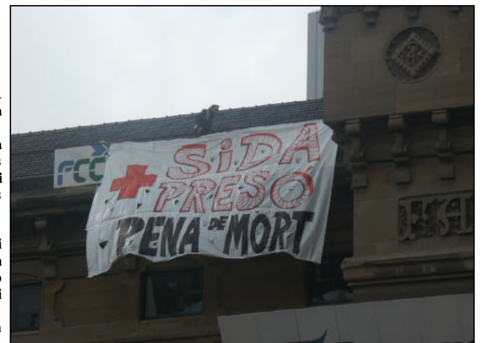
Pancarta desplegada al capdamunt de l'Hospital Clínic de Barcelona.
