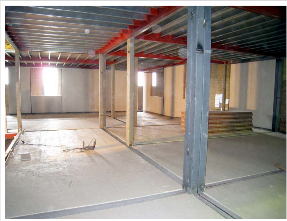
Estructuras de acero para nuestros módulos de 3x6x3,30 metros
